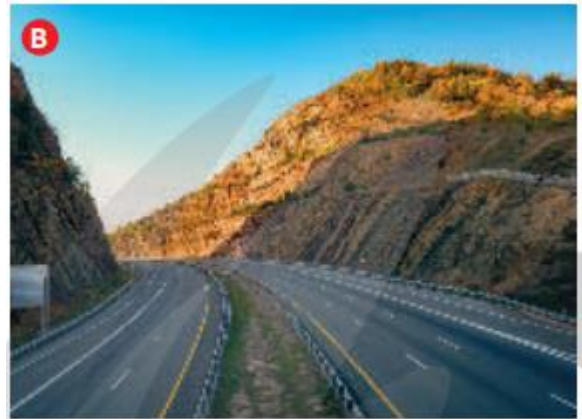
Estrada cortando montanha no estado de Nova Jersey, Estados Unidos (2015).
