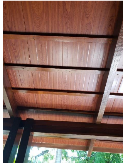
DETALHE CHAPA INFERIOR DA TELHA – AMADEIRADO
